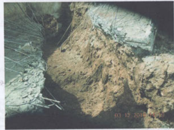
Նկար-4.1 Դատարկություններ (հարամիներ) Արմավիրի Մայր ջրանցքի հարակից մասում
